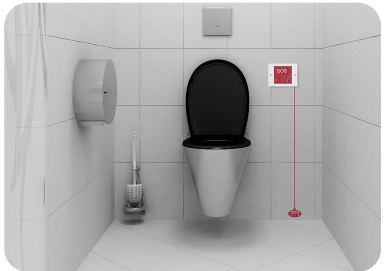
Das Zugseil hat eine barrierefreie Kennzeichnung.
